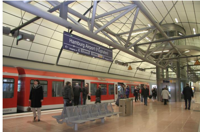
Abbildung 98: S-Bahn-Station Hamburg Airport.
